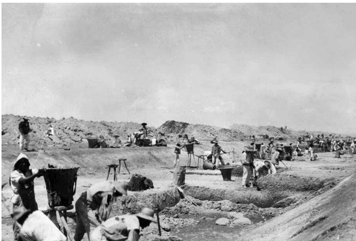
FOTOTECA LÁZARO CÁRDENAS, ▶ Álbum 1, foto 82. Construcción del Dren Guaracha, 1937.
