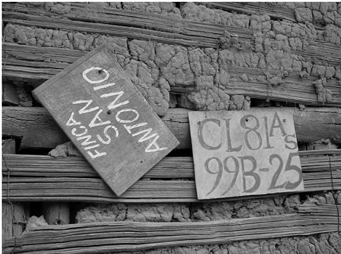
Antigua casa de Matilde Cobos (q.e.p.d.) construida en Bahareque con la nomenclatura rural y la urbana, 2003.
