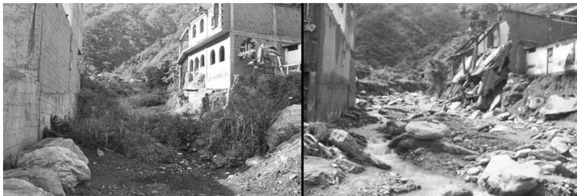
En las fotos se aprecia el estado en el que quedó el barrio Quebrada Seca (estado Vargas, Venezuela) luego de los aludes de diciembre de 1999; la zona continuaba habitada a pesar de hallarse sobre el propio cauce del río. A la derecha se observan los efectos de las lluvias de febrero de 2005 en el mismo lugar.
