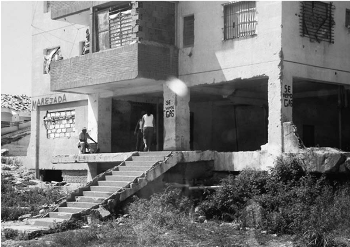
Edificio Marejada, en Los Corales, estado Vargas, Venezuela, en su situación actual, luego de los efectos de los aludes de diciembre de 1999. Este edificio no ha sido desalojado hasta el presente.
